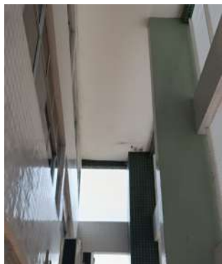
Foto 04: Área do forro com presença de infiltrações.
