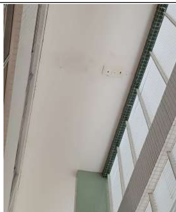
Foto 06: Área do forro com presença de infiltrações.
